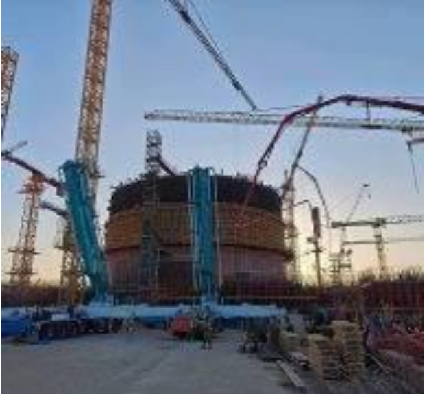
صور لأعمال صب المفاعلات بمحطة الضبعة النووية ٢٠٢٣-٢٠٢٤
